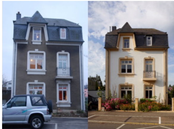
Fassadendämmung: vorher / nachher
