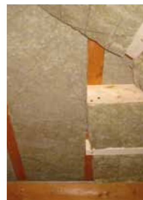
Isolation pans du toit
