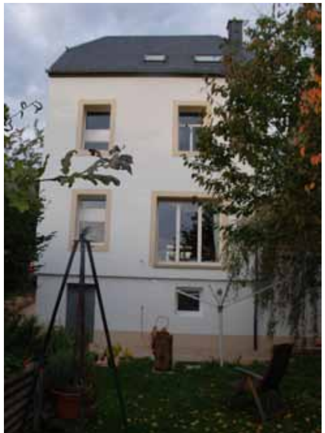
Nach Sanierung mit Außenwanddämmung
